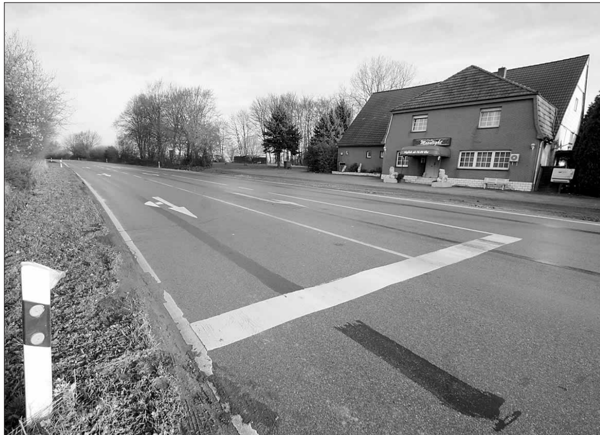
Die Kreuzung Laarer/Lübbecker Straße am Nachtclub | Landesbetriebs Straßen NRW wurde auch 2006 noch »Moon-Light«: Trotz mehrfacher Zusicherung des | kein »Angebotsstreifen« markiert. Foto: Schelberg
